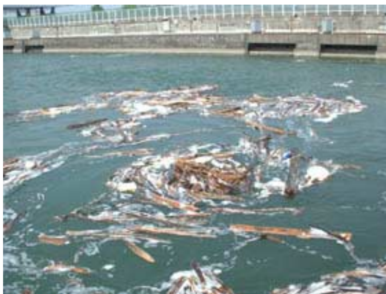
Déchets à l'amont de l'usine
