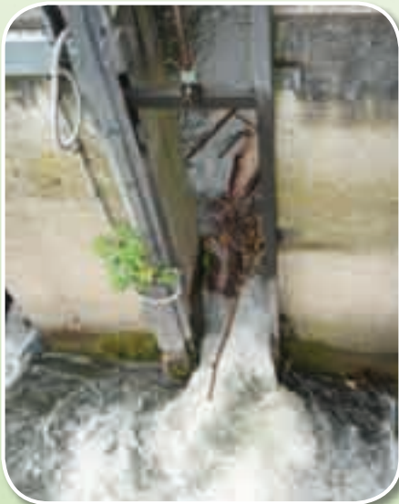
Passes à poissons obstruée
