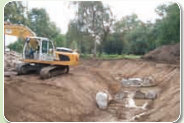
Pose de blocs dans la passe à poissons d'Avolsheim
